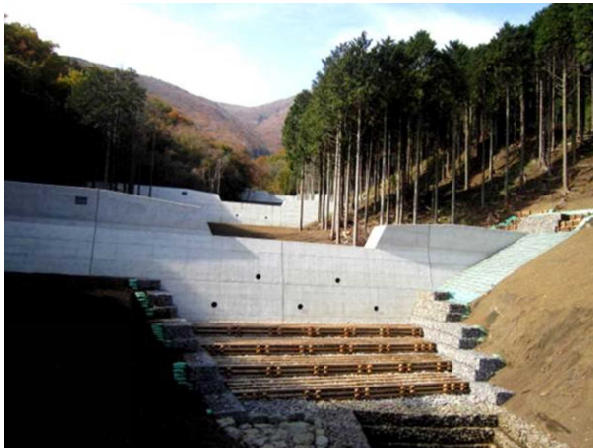
写真⑤施工後 北郷地域（角取山1）
