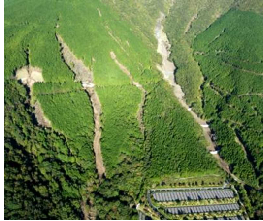
写真①拡大する崩壊地
