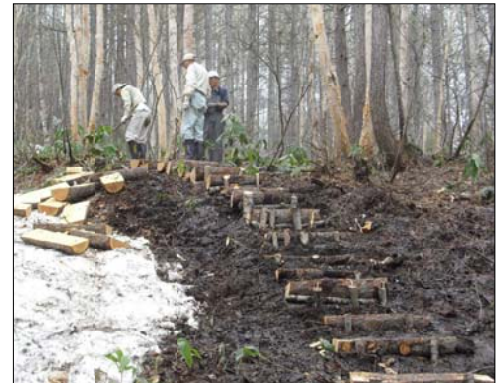
遊歩道の整備作業
