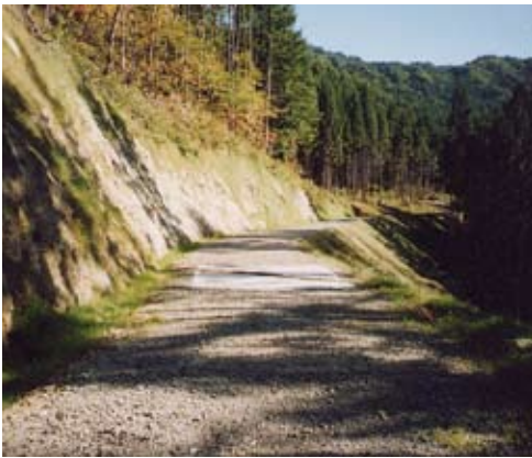
完成した林道
