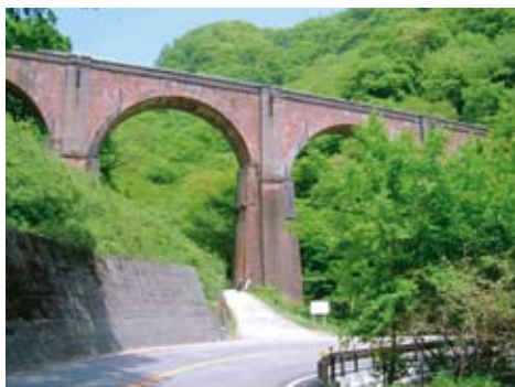
通称「めがね橋」 （群馬県松井田町）
