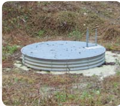
集水井工（妙見地区）
