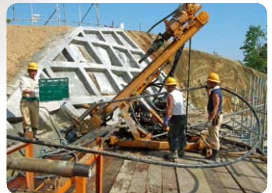
アンカー工（呼坂地区）
