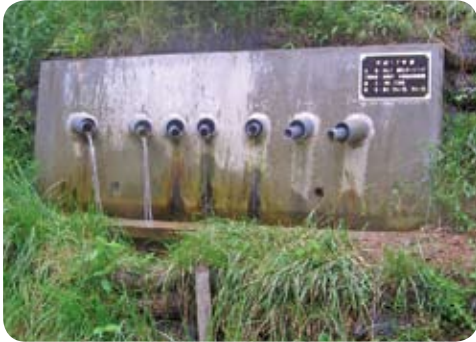
横孔ボーリング排水工（風口地区）
