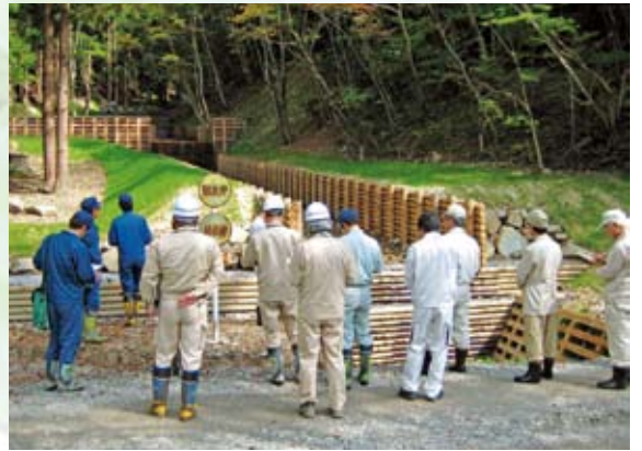
間伐材を多用した治山工事箇所の視察
