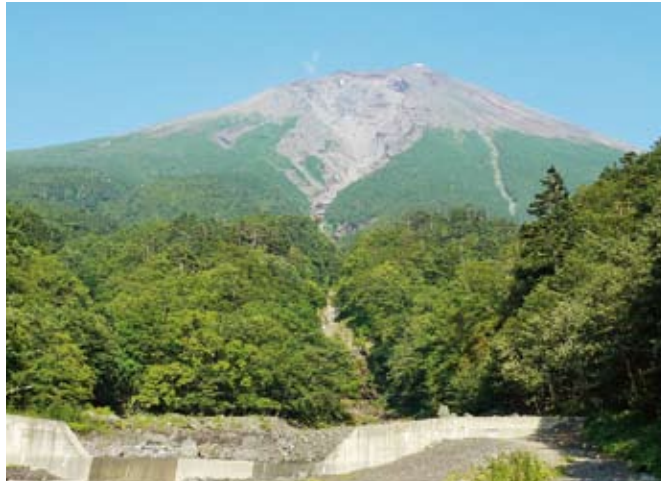
崩壊がつづく大沢崩れ
