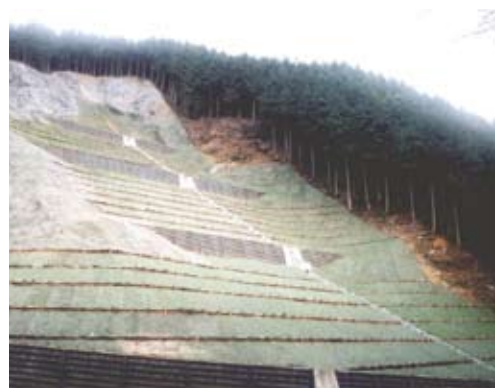
復旧治山事業（山腹工） 栃木県日光市
