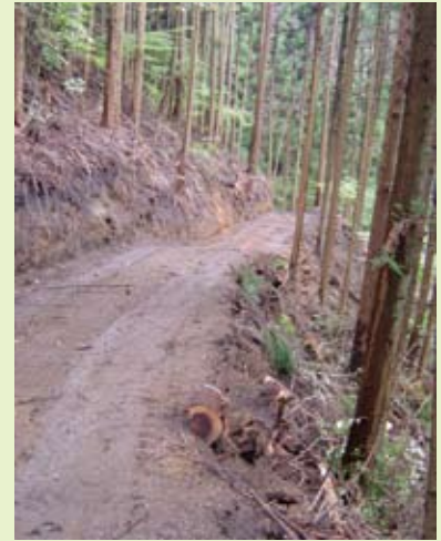
群馬森林管理署管内の 低コスト作業路 (根株・丸太を利用した土留)
