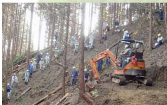
塩那森林管理署管内国有林で行われた低コスト作業路作設現地研修会
