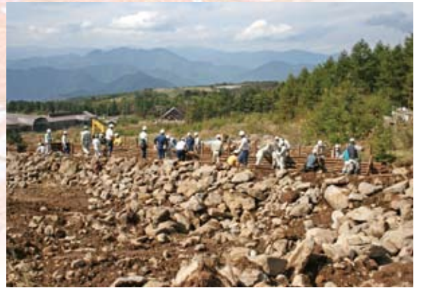
転石を利用した水路及び丸太柵工の作設状況
