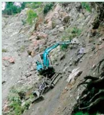
機械施工によりコスト縮減が図られ、かつ、安全に施工できた(急斜面でも自走できる高所作業法切機械の作業状況)
