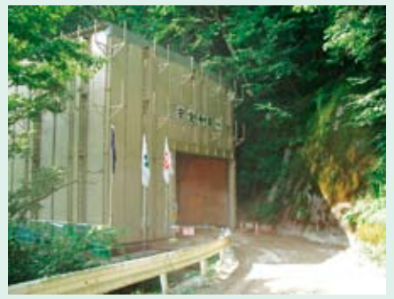
猛禽類に配慮して、防音シェルターで覆ってトンネル排水工を実施(写真はシェルターの入口、トンネルの入口はシェルター内にある)
