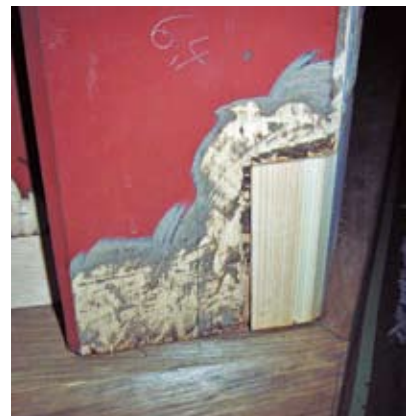
腐朽部位の修復作業(二荒神社)
