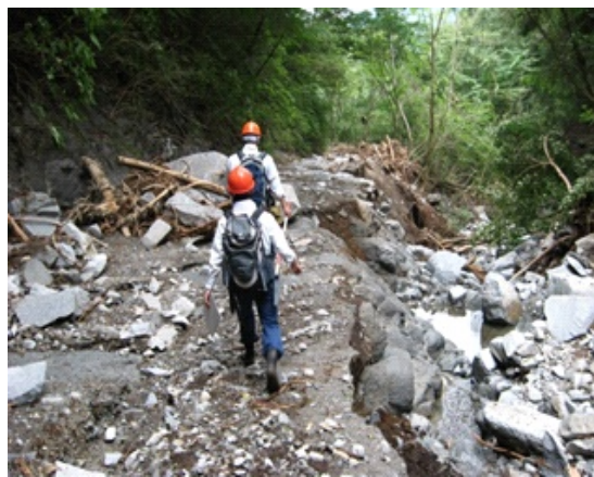
土砂崩れにより路体が崩落、徒歩での調査
