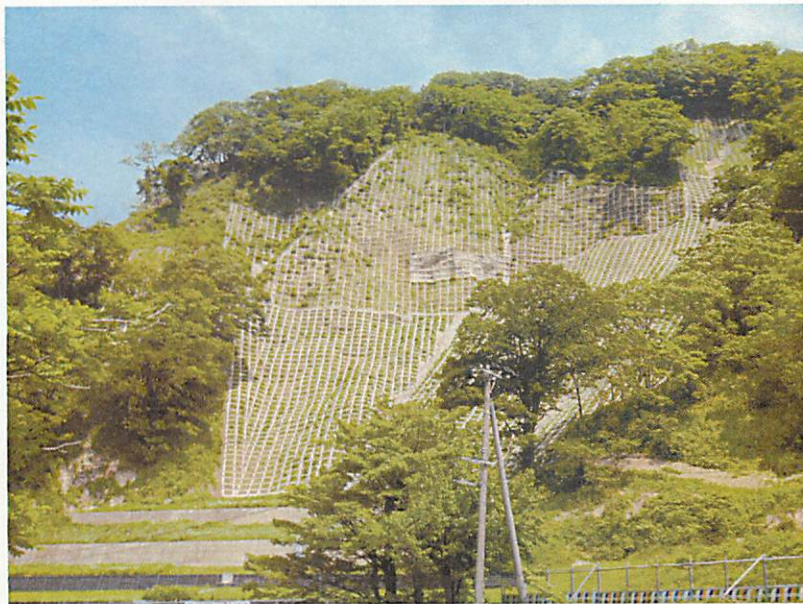
「法枠工などの工事が行われている「貫（つなぎ）地区」の現場」
