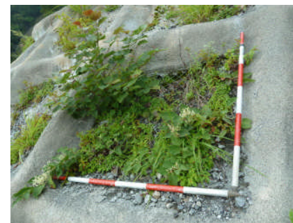
(写真1) 法枠内：特殊配合モルタル
