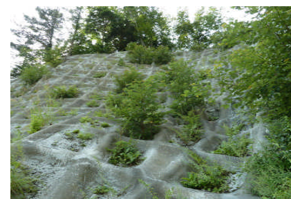
(写真2) 対策後の法枠内の植生状況
