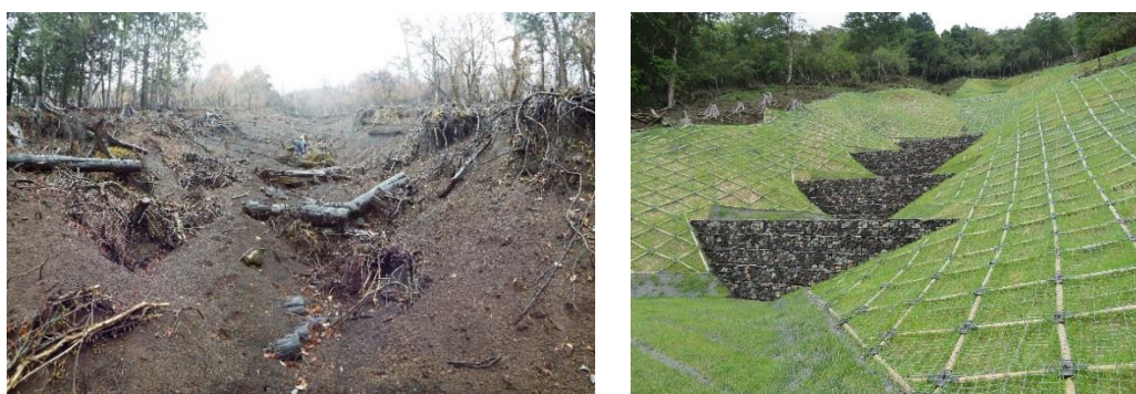
小山町での治山工事の実行前後
