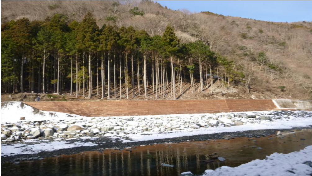
間伐材を多用して景観にマッチした残存型枠工
