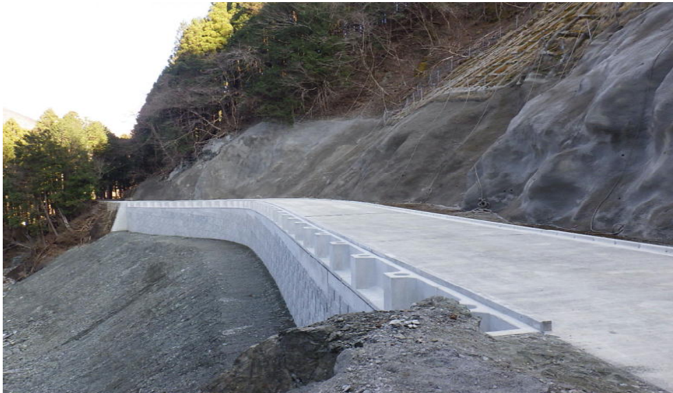
難所に初めて導入した垂直壁の補強土壁工
