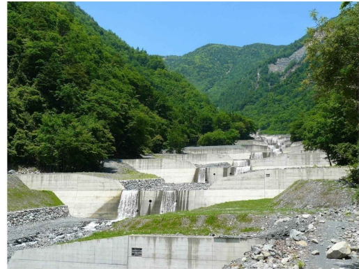
復旧状況(H20)
