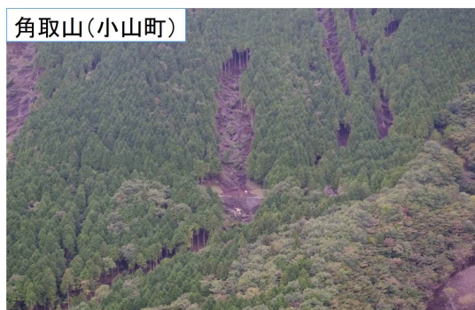
崩壊状況 (H26)
