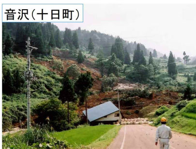
被災状況 (H17)
