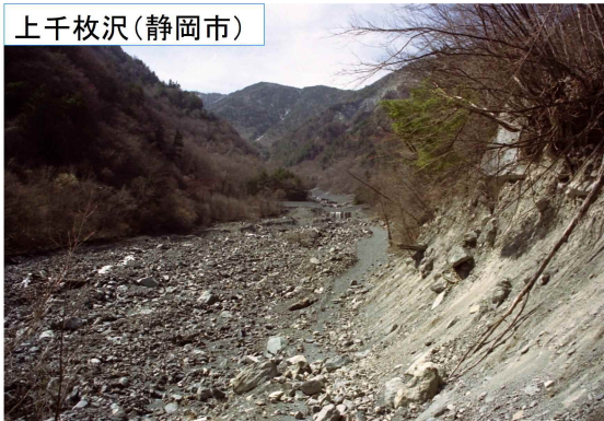
崩壊状況(H13)
