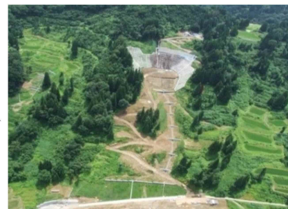
復旧状況 (H19)
