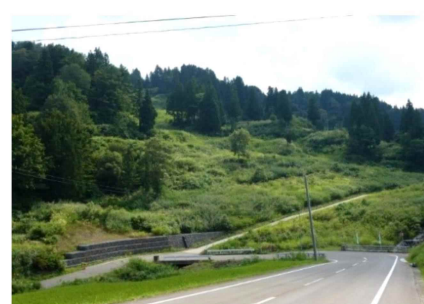
復旧状況 (H25)
