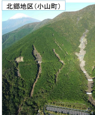
崩壊状況 (H26)
