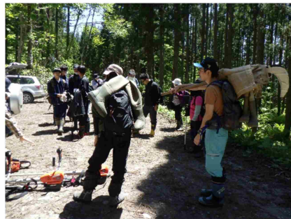
▲ 2022年6月 (南ヶ谷湿地での排水堰修繕作業)
