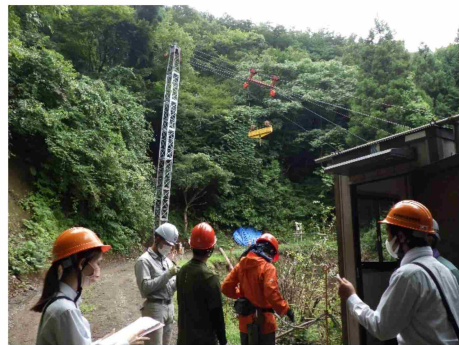
▲ ケーブルクレーンの 遠隔操作の説明
