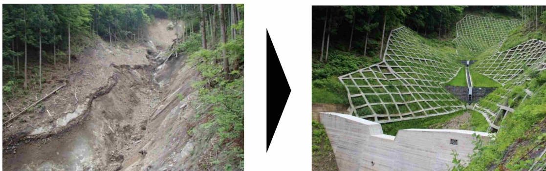
H27関東・東北豪雨災害（日光森林管理署管内）の復旧状況
