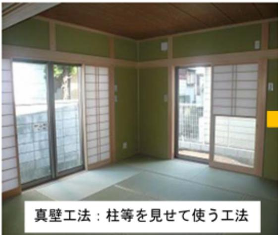
真壁工法：柱等を見せて使う工法
