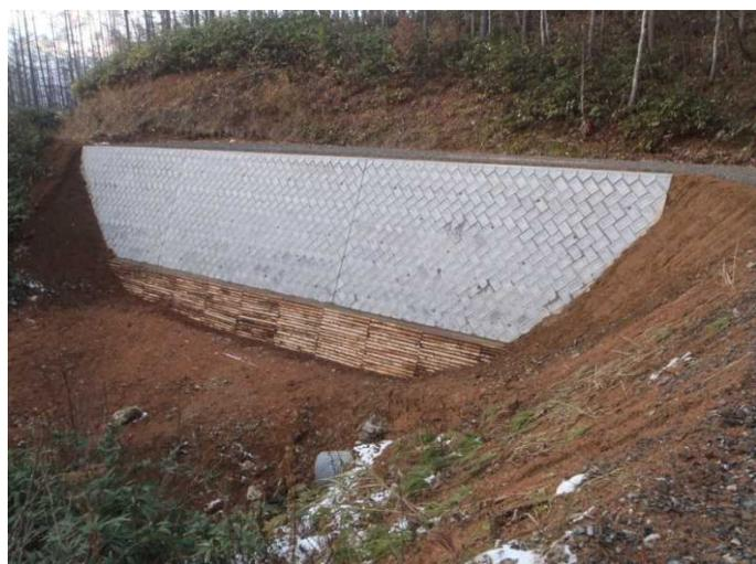
間伐材を基礎型枠に用いた林道災害復旧工事(南会津町)
