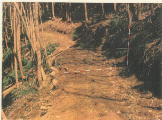
低コストで壊れにくい作業路（群馬森林管理署管内）
