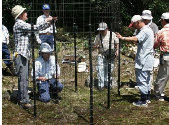
柵設置の様子
