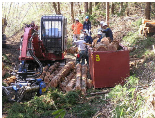
現地見学会 高性能林業機械プロセッサーによる造材と専用コンテナへ積み込み
