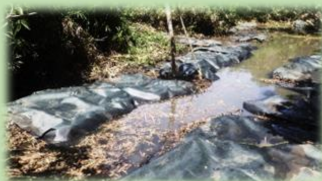
刈り払い後に防草シートを設置
