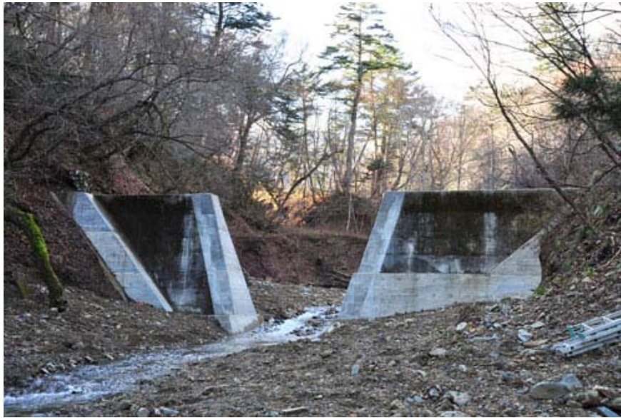
写真6 2009年11月に中央部を撤去した「茂倉沢2号治山ダム」
