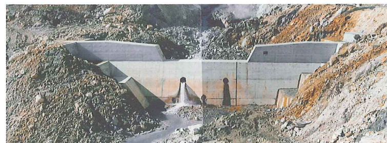
第11治山ダム (S63) H=5.0m L=30.0m
