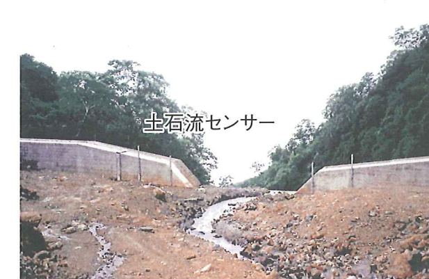
第6治山ダム H=18.0m
