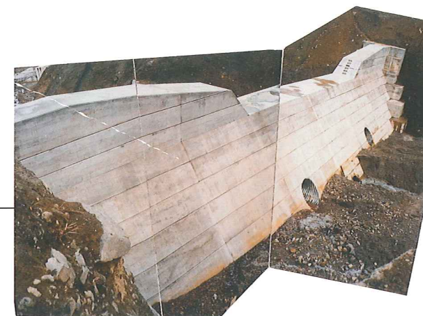
第2治山ダム (S54-57) H=12.5m L=60.0m
