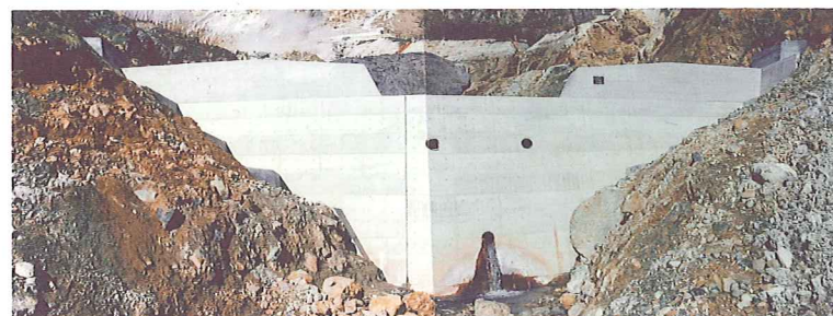
第10治山ダム (S63) H=8.0m L=36.4m
