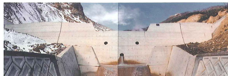
第7治山ダム (S61) H=7.0m L=50.0m
