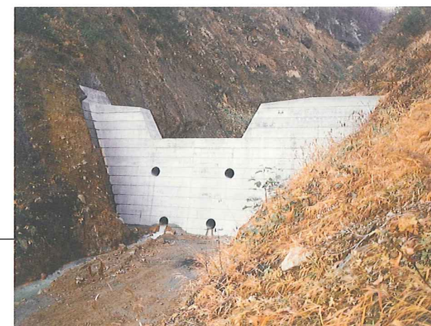
第4治山ダム (S59) H=11.0m L=39.0m
