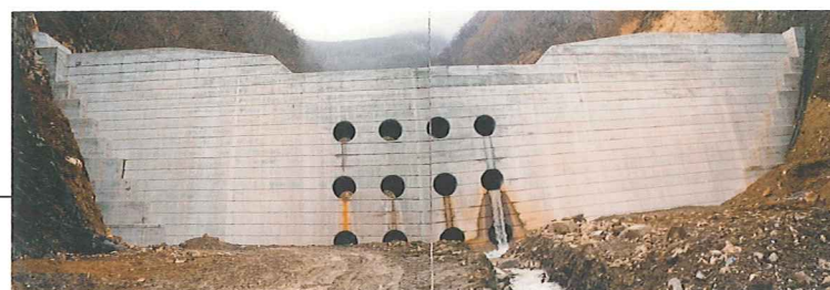
第3治山ダム (S55-58) H=21.0m L=78.0m
