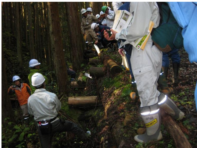
〔盛土のり面の丸太組工〕
