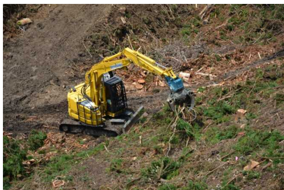
グラップルによる地拵作業
