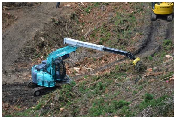
ロングリーチグラップルによる地拵作業
