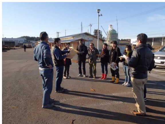
宮の郷木材流通センター。背景は建設中のバイオマス発電
