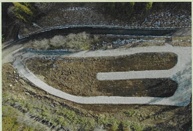
民有林材と協調出荷するための土場を設置
