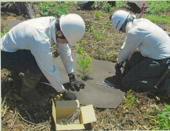
下刈省力化：防草シートの設置
