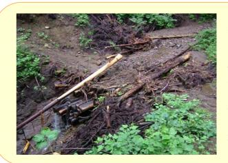
沢の横断は洗越(あらいごし)工 写真は出水による被災直後 流木と土砂を取り除けばすぐに 通行可 盛土の 技術革新
