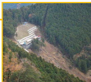
施工中の状況
