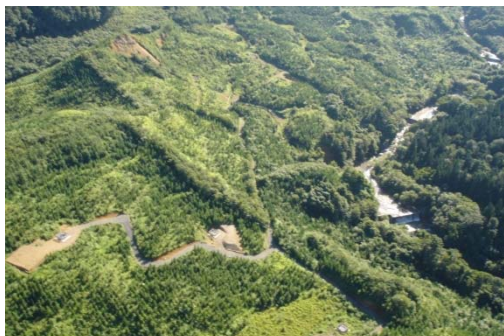
（磐井川（事業実施地区）の状況）
