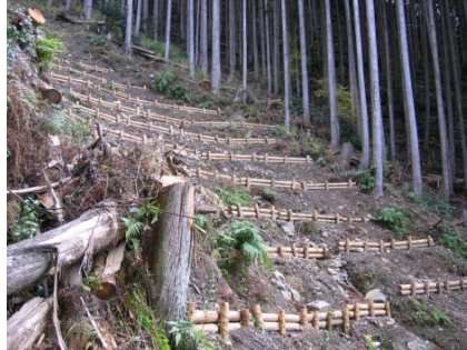
現地発生材を活用した丸太筋工
