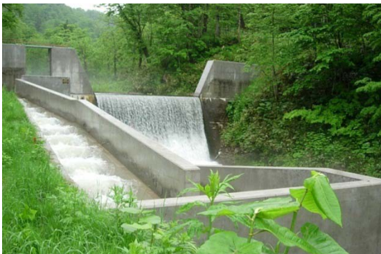
治山ダムにおける魚道の設置
