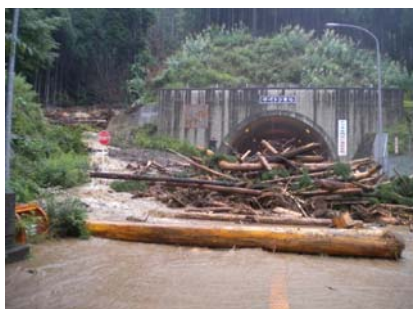
国道への氾濫・流出
