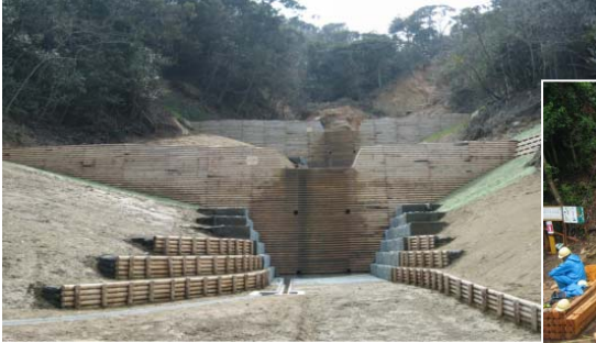
木製残存型枠
