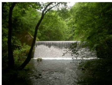
溪間工（治山ダム）
