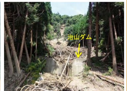
治山ダムにより崩壊や侵食の拡大等を抑制
