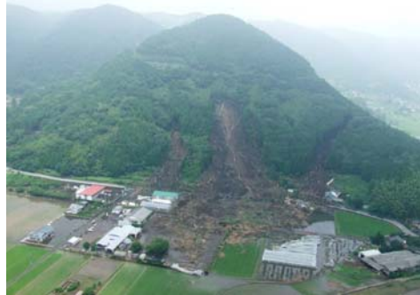
平成24年7月九州北部豪雨災害 梅雨前線に伴う豪雨により山腹崩壊が発生し、人家、市道、農地が被災。 (熊本県阿蘇市)
