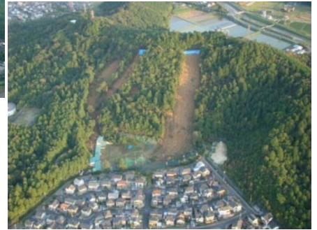
平成25年台風18号災害 豪雨により山腹崩壊が発生し、市道が被災。 (滋賀県栗東市)
