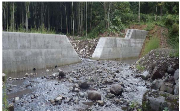
治山ダム放水路の複断面化
