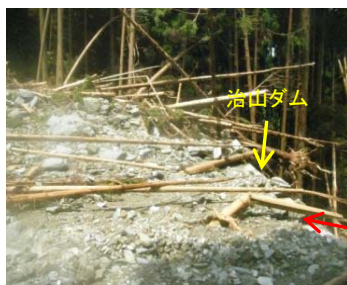
（治山施設設置箇所） 治山ダムにより崩壊や侵食の拡大を抑制
