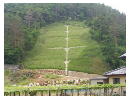
崩壊地（発生源）の復旧
