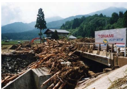
流木により橋が閉塞
