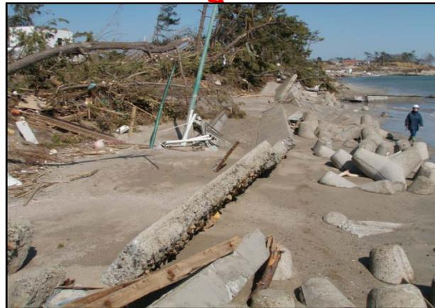
護岸工・根固工が約800mにわたり倒壊
