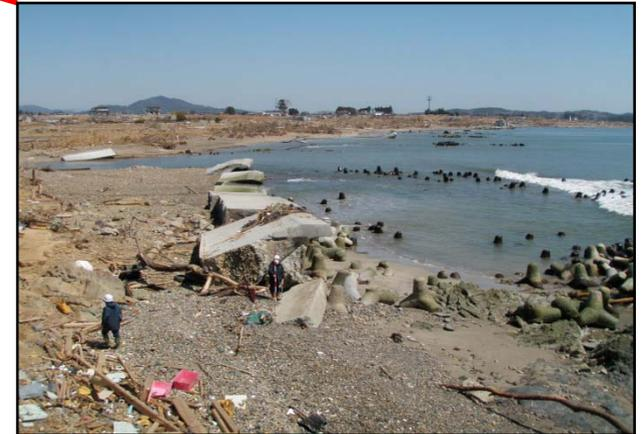
護岸工の倒壊、地盤沈下による浸水被害
