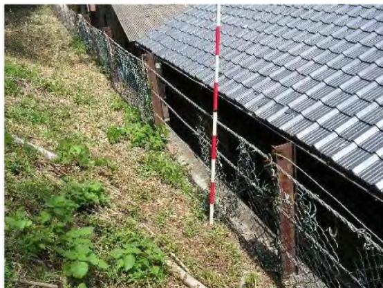
当初施設の完成状況
