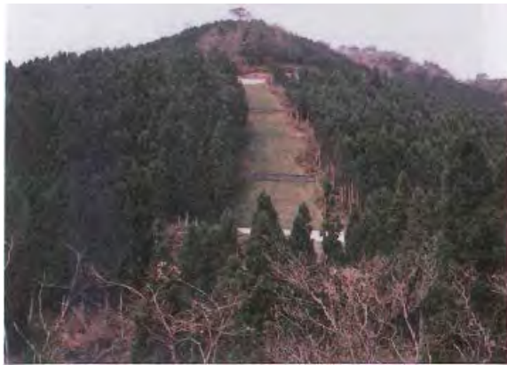
山腹工（施工直後）
