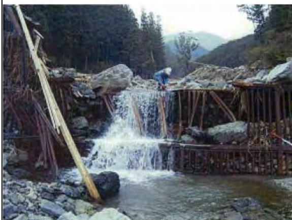
堤体破損，中詰材流出 損傷状況
