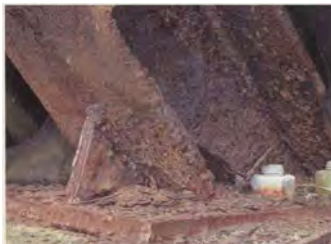
脚部の腐食が顕著な状態
