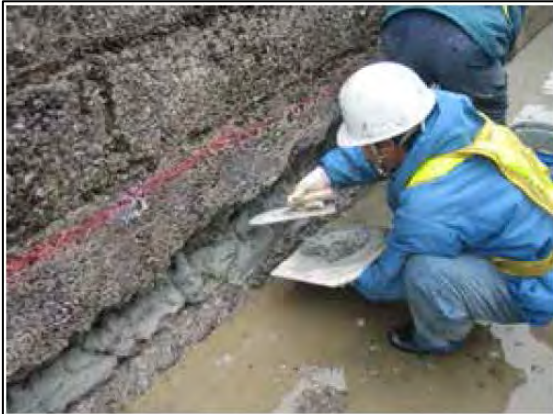
写真 4. 2. 1-1 断面修復材の充填
