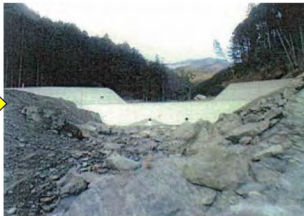
コンクリート谷止工施工 対策実施状況
