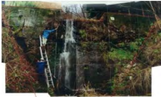
破損状況（右岸袖部に浮き）
