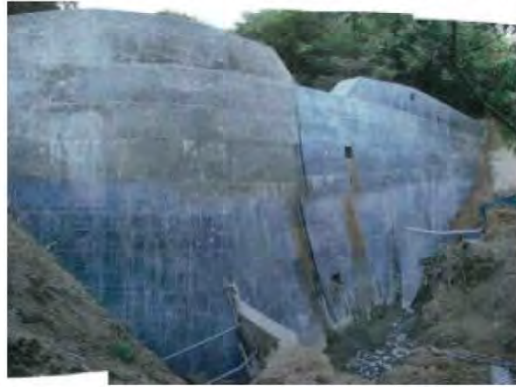
既設谷止工 損傷状況
