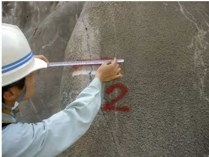
図 10 スプレーによるマーキングの事例
