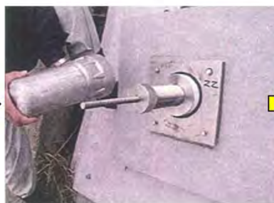
取付け作業中
