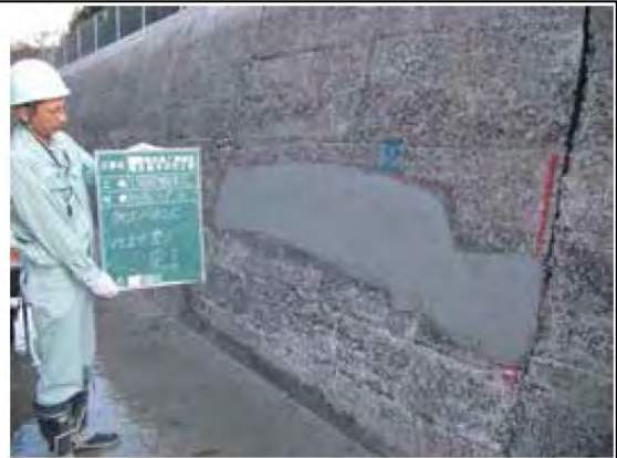
写真 4. 2. 1-2 断面修復終了後
