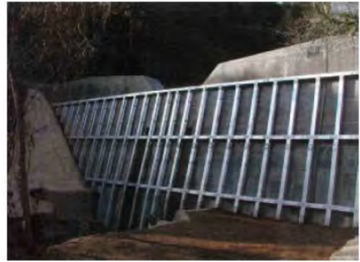
施工後(鋼材補強) 対策実施状況
