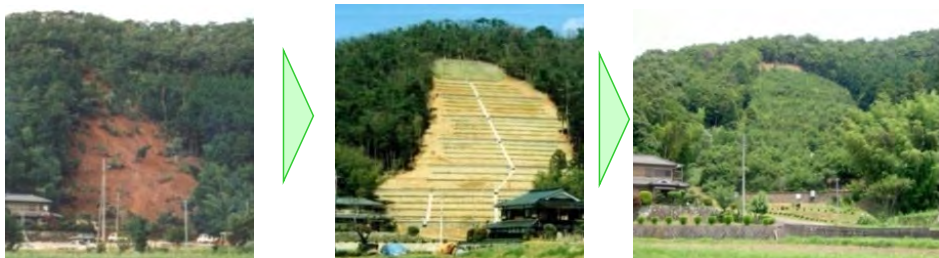
写真 3 山腹工の定点撮影の例（左：崩壊発生時 中：山腹工施工直後 右：施工約10年後）
