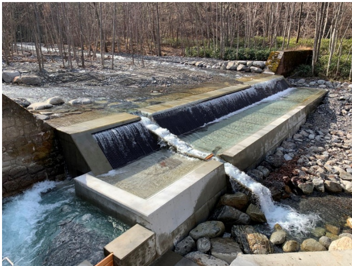
治山ダム(管理主体：中部森林管理局 中信森林管理署)と取水施設 (国有林)
