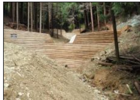
治山ダムの設置状況
