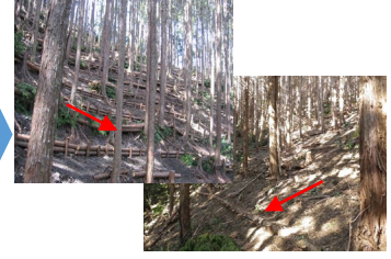
筋工の設置による土壌の保持
