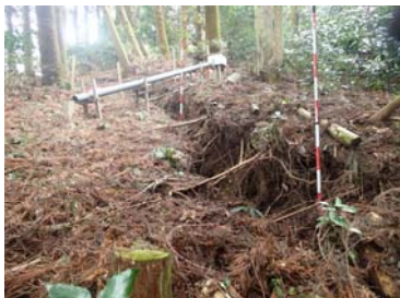
① 冠頭部亀裂状況
