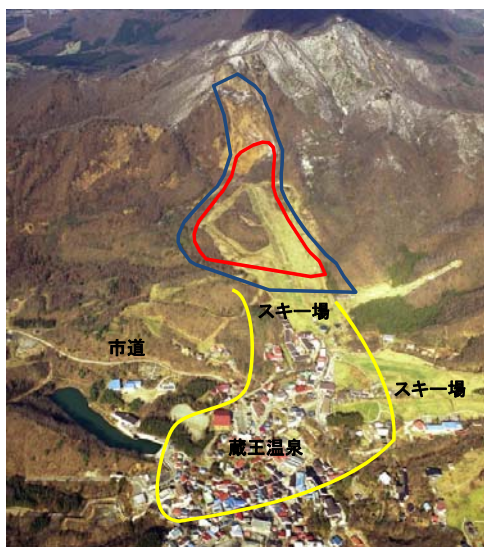
③ 龍山地すべり防止区域 全景
