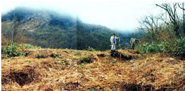
① 地すべりにより発生した段差
