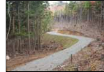
矢櫃山国有林 618林班 (九十九沢林業専用道)
