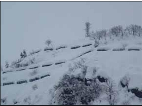
施工効果(防止柵工によるなだれ発生の防止)
