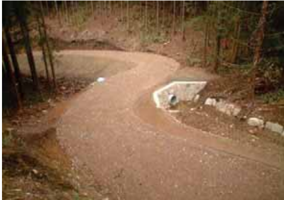
鈍引沢林道新設
