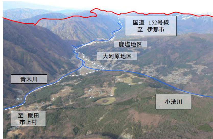
保全対象(北部)
