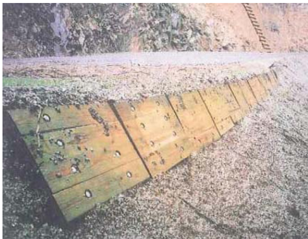
柵工・土止め工
