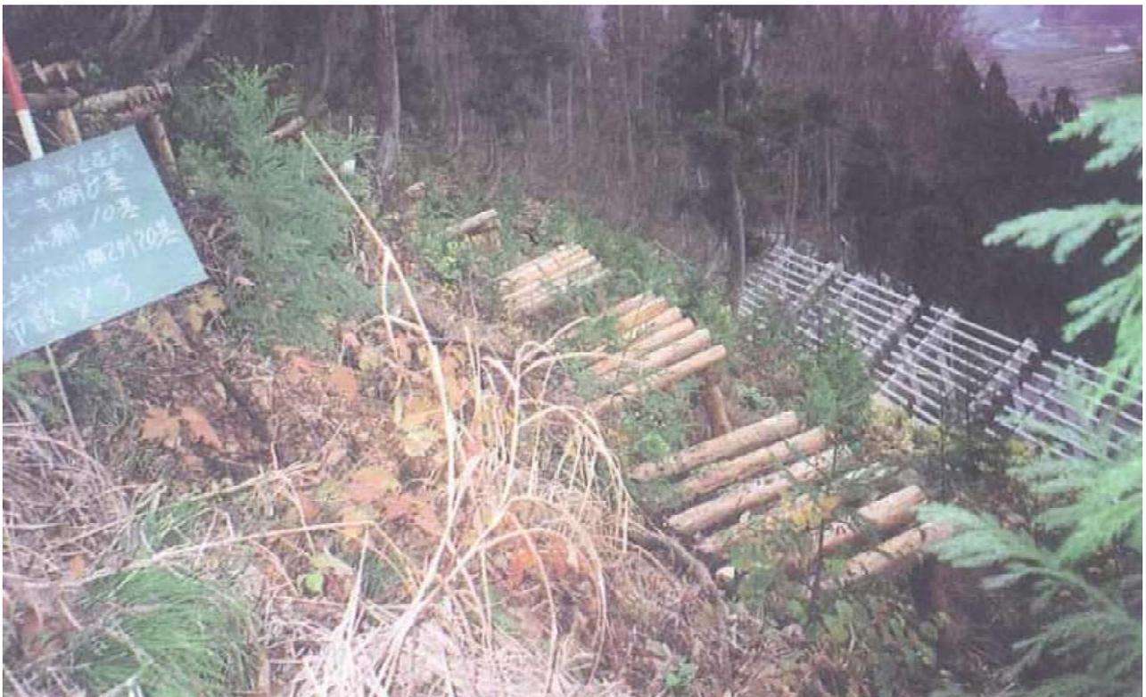
平成5年度8基設置（間伐材材積 5,209 m<sup>3</sup>）柵間隔：横1～2m 縦5～6m
