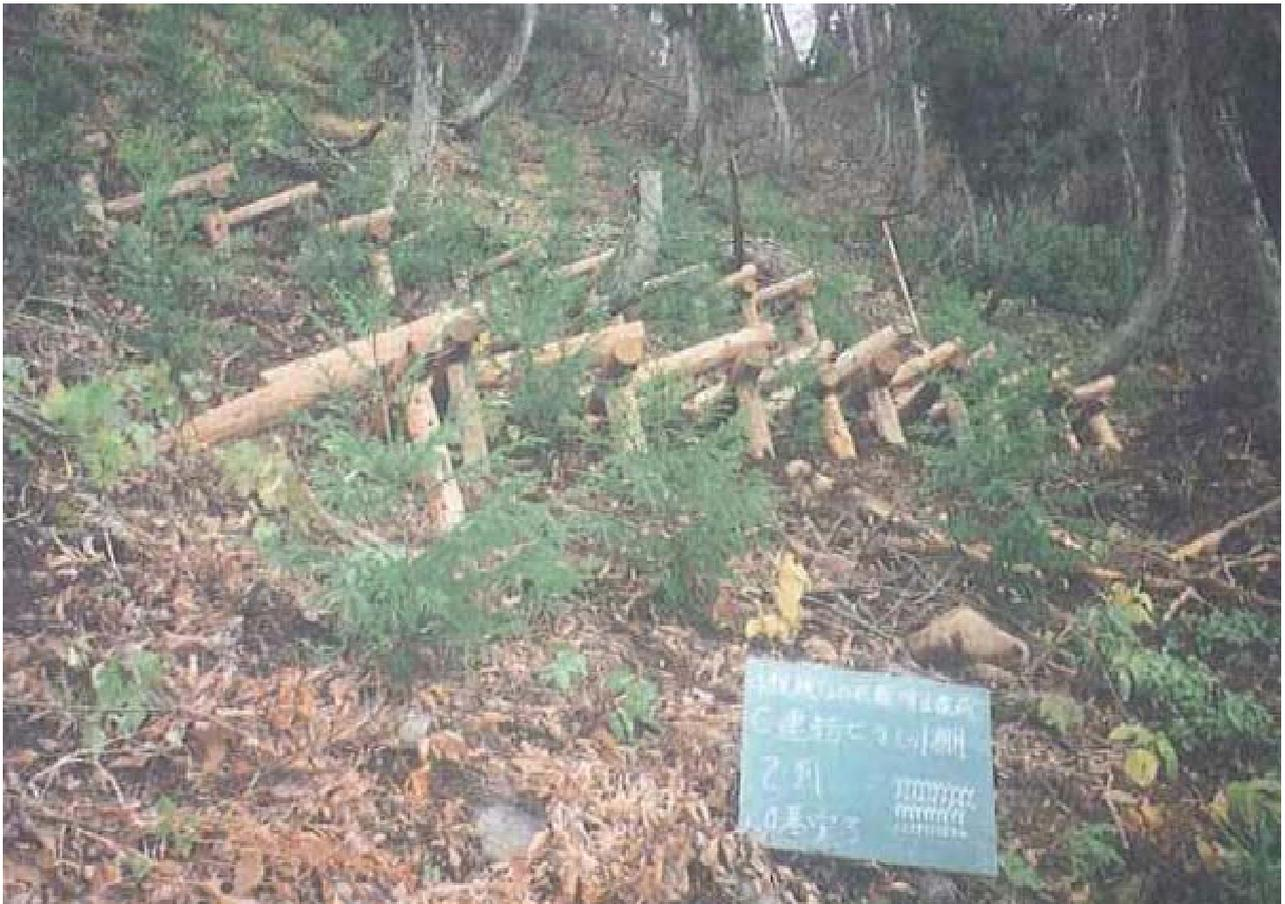
平成5年度10基設置（間伐材材積0.588 m<sup>3</sup>）格支柱頭間隔：横4～5m 縦2～3m
