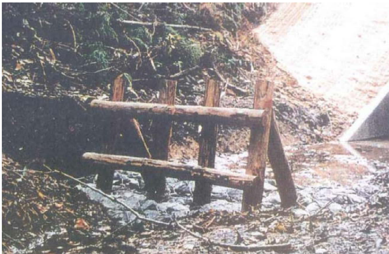
流木除け工 H=1.5m 型（布団籠設置）
