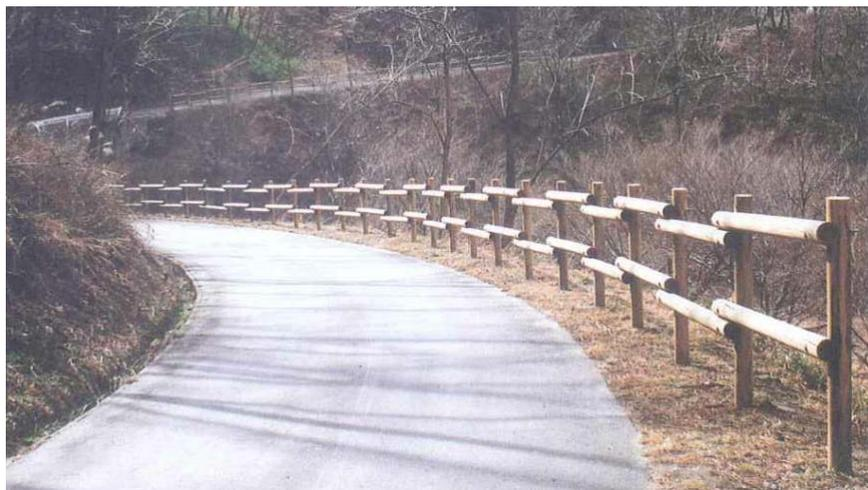
平成 11 年度施工 / L=116 m スギ間伐材 (丸棒加工) 4 m<sup>3</sup>
