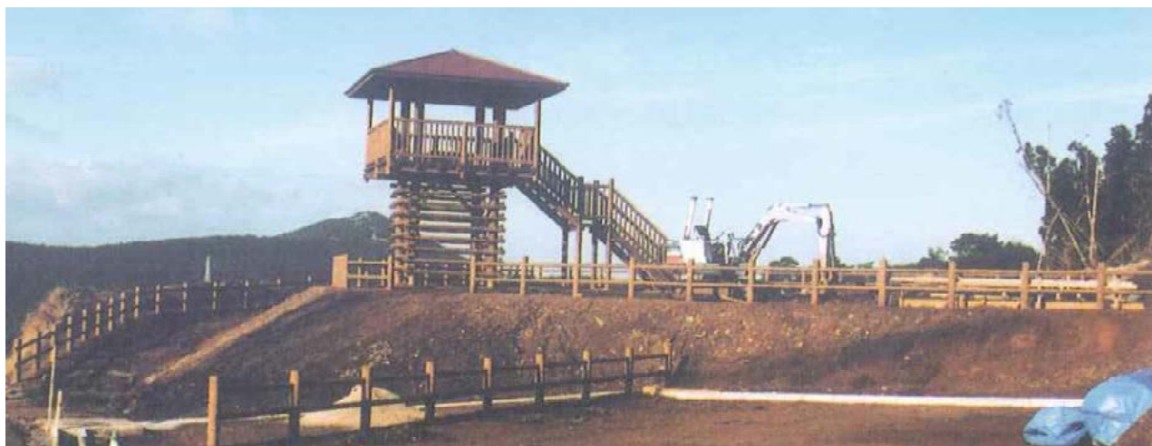
木柵 平成 12 年度施工 L = 118.5m 杉材 3.7 m 3 使用
