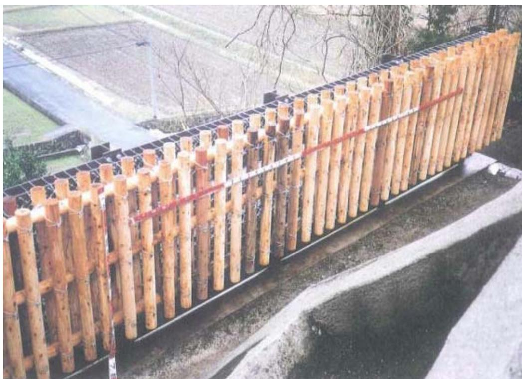
落石防護柵の緩衝材に使用 平成 11 年度施工
